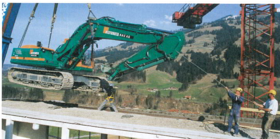
Der 36 t schwere Hydraulikbagger Volvo EC 340 schwebt am Haken eines Autokrans und wird in eine Öffnung des Silodachs transportiert. Von hier aus begann er mit dem Rückbau der annähernd 20 000 m 3 Beton, die auf einer Inertdeponie abgelagert werden. (Fotos: Ma)
